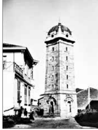
Kaleiçi dörtyol ağzında yol yapımı sırasında Belediye tarafından yıktırılmıştır.
