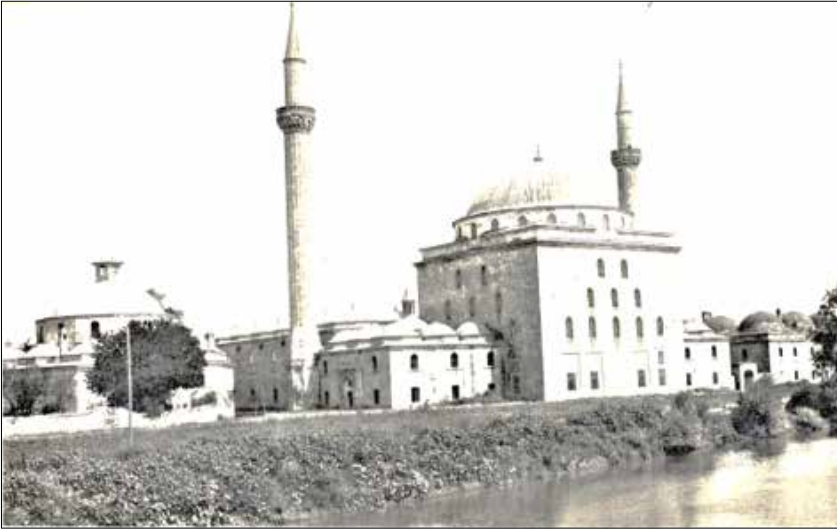
II. Bayezid Camii'nde Hünkâr kapısı önündeki rıhtımlar ve Hünkâr kapısının kaldırıldıktan sonraki hali. 153
