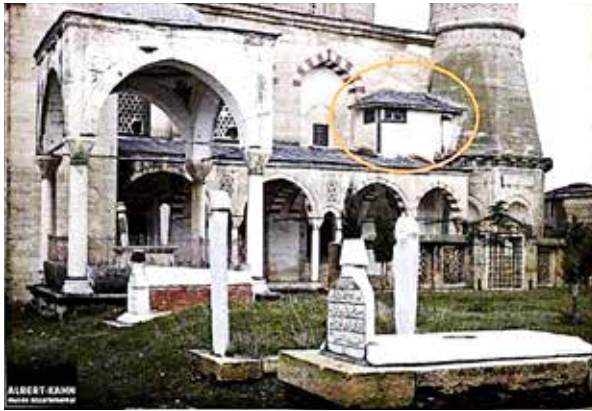
Resim 9: 7 Kasım 1922 tarihinde Albert Kahn isimli bir Alman gezgin tarafından, Selimiye Camii haziresi tarafından çekilen fotoğraf ve 1837 yılında eklenen muhdes yapı.
