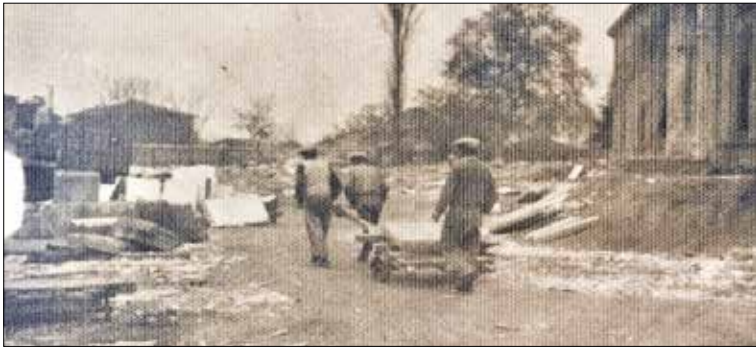
Selimiye Camii’nin minarelerinin tufan sonrası tamiri. 90
