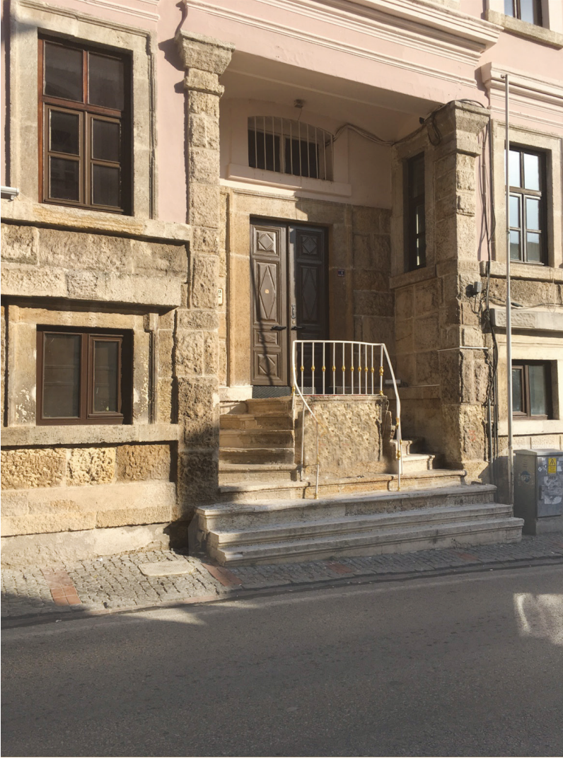
Kaleiçi Maarif Caddesi'ndeki taş bina da Duyûn-ı Umûmiye binası olarak kullanılmıştır.
