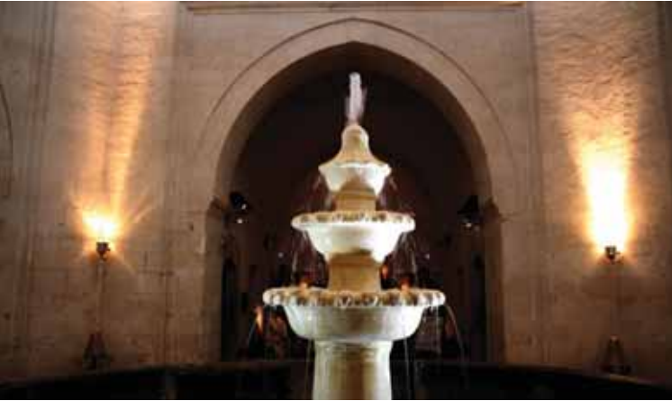
Edirne Darüşşifası'nın merkezinde bulunan şadırvan
