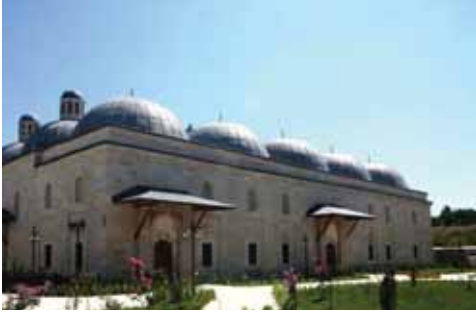
Külliyenin mutfak, aşevi ve mumhânesinin bulunduğu imaret bölümü
