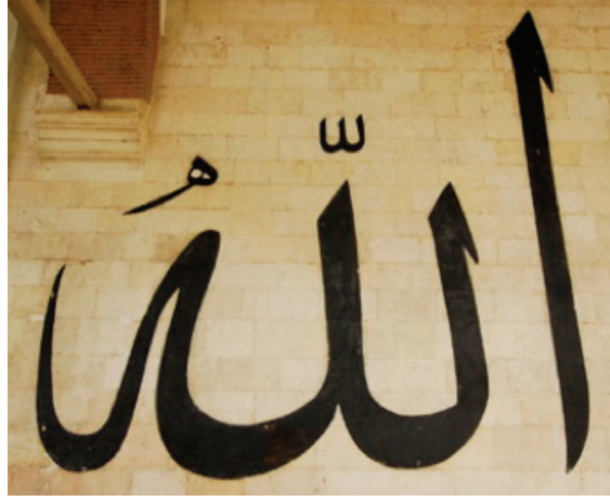
Fotoğraf 73 - Son cemaat mahalli duvar yüzeyi yazıları
