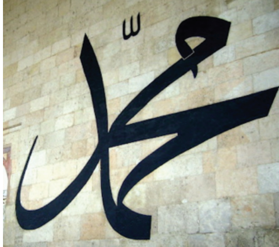
Fotoğraf 74 - Son cemaat mahalli duvar yüzeyi yazıları
