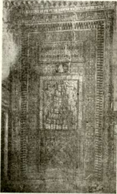
Muradiye Camii mihrabının eski hâli
