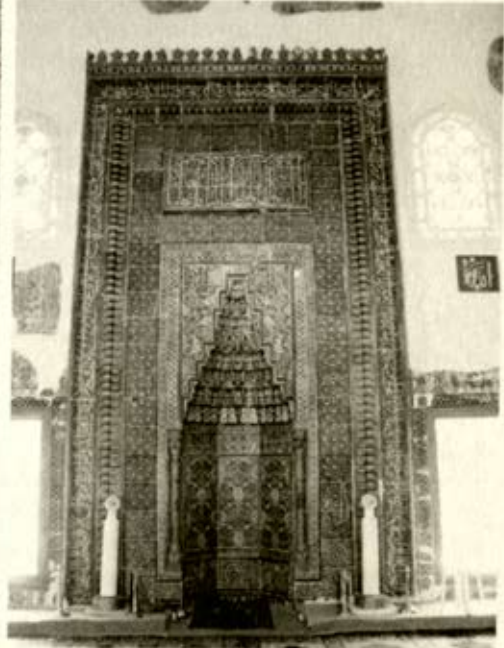
Muradiye Camii mihrabının şimdiki durumu
