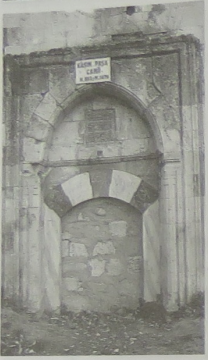
Kasım Paşa Cami'nin taş örü- lerek kapatılmış bulunan iç giriş apısı - 1989
