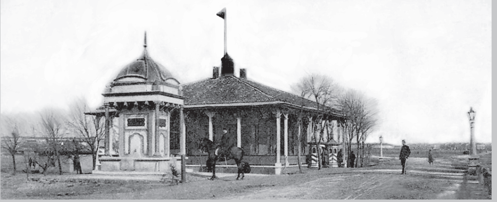
Edirne Karakol Binası - 1904
