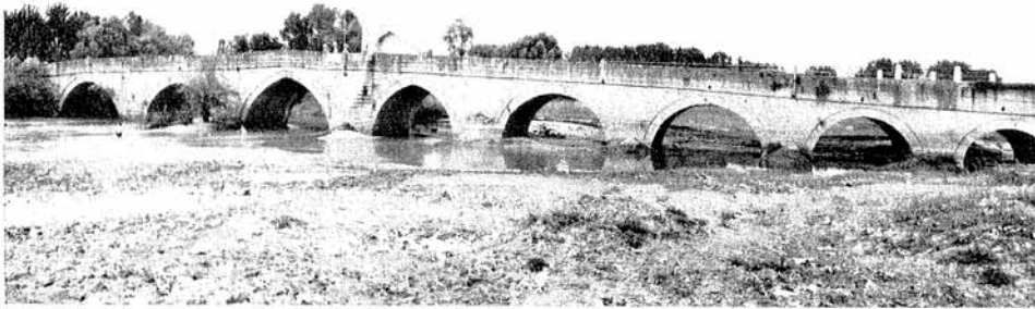
Edirne'de Şihâbüddîn Paşa Köprüsü
