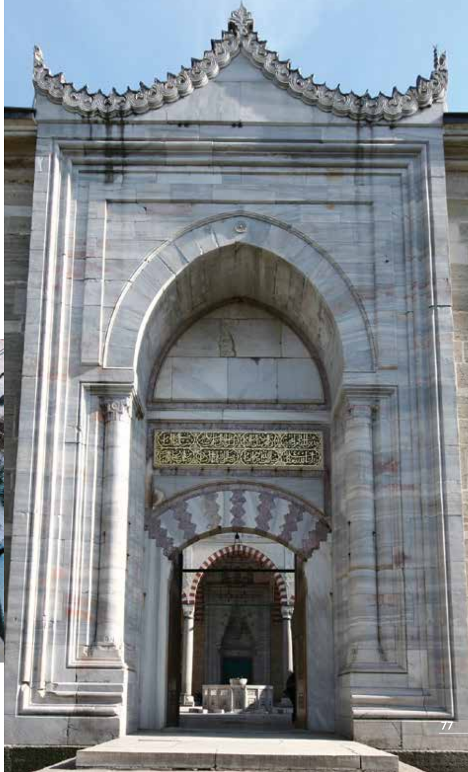
Selimiye Taç Kapısı
