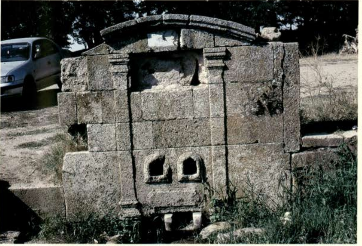
Karaağaç Mahallesiinde Demirtaş Çeşmesi
