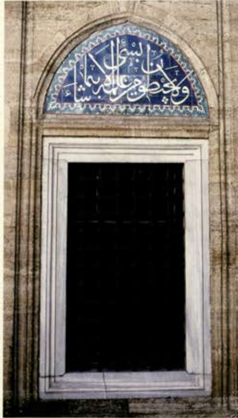
Selimiye Camii avlu pencere alınıđı
