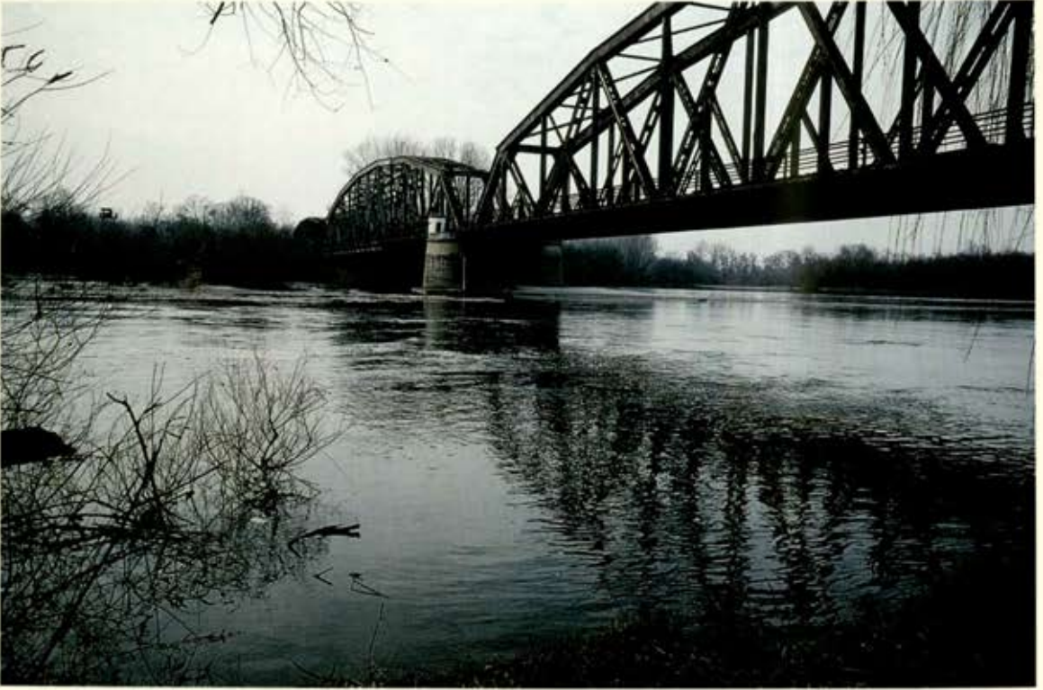
Meriç Nehri üzerinde demiryolu köprüsü
