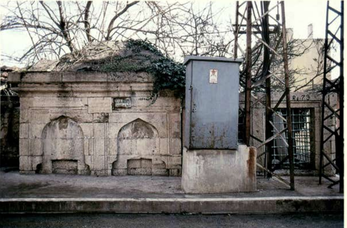
Uzunkaldırım Caddesinde İki Lüleli Çeşme
