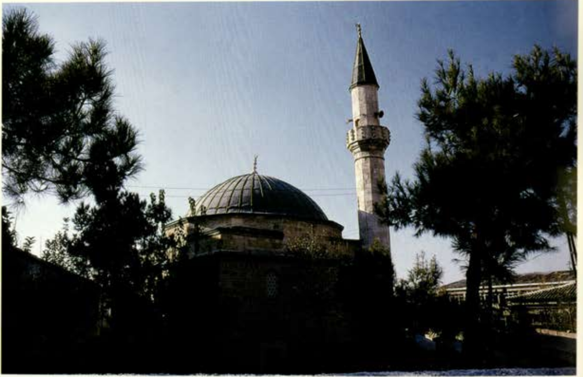
Sarıca Paşa Mahallesinde Sarıca Paşa Camii
