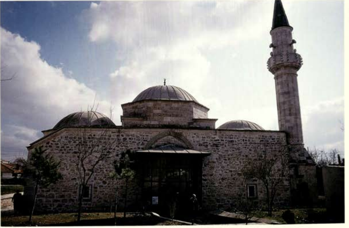
Abdurrahman Mahallesiinde Yeşilce Camii
