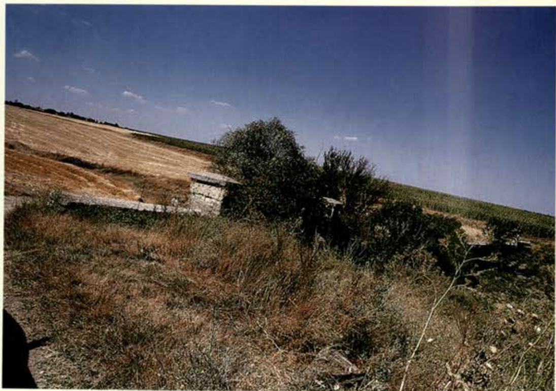
Kemerlerde Havalandırma Bacası
