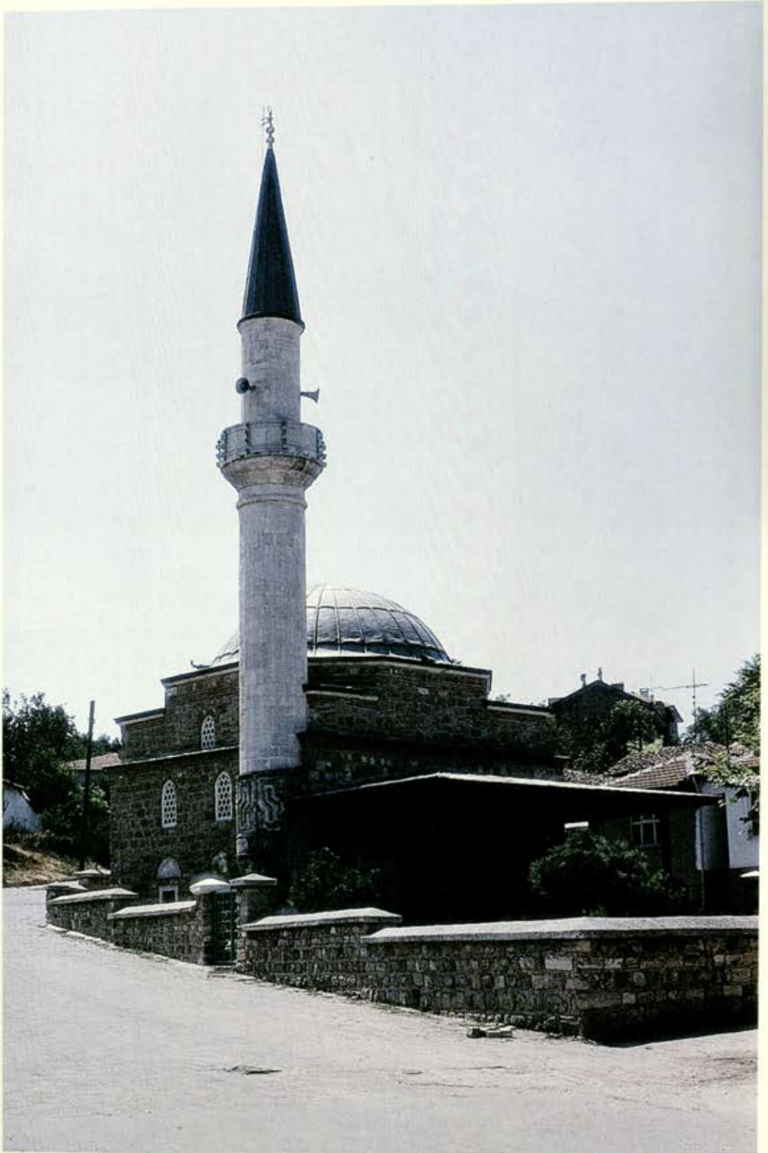
Bâba Demirtaş Mahallesiinde İsmail Ağa Camii
