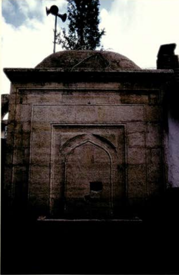
Abdurrahman Mahallesinde Hacı Ali Çeşmesi
