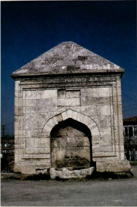
Menzilahır Mahallesi Muradiye Camii Çeşmesi
