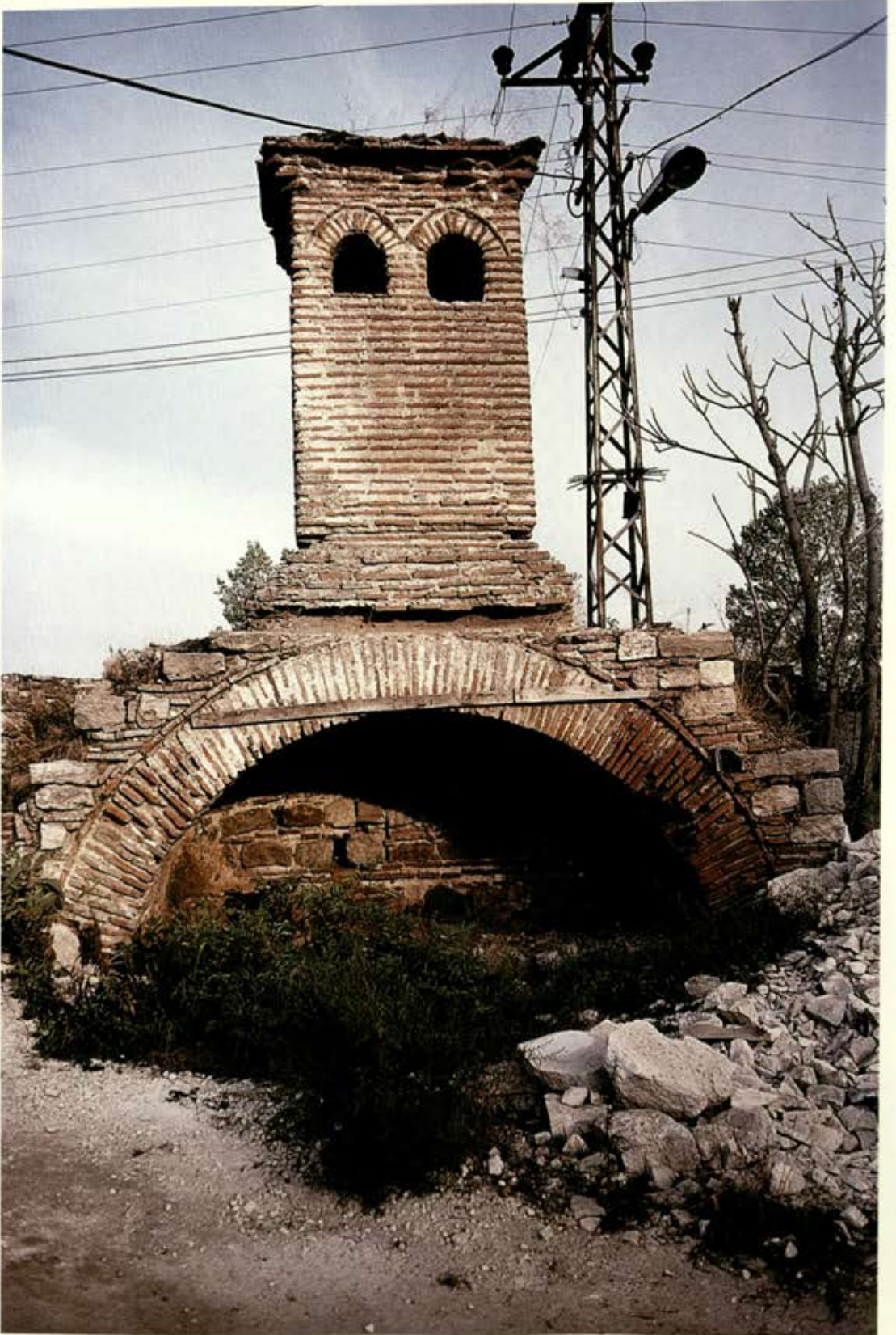
Yıldırım Bayezid Camii Aşevi mutfak bacası
