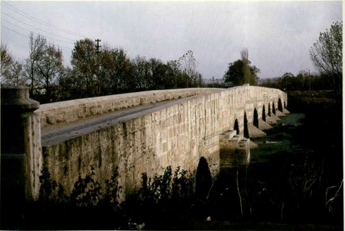
Mihal Köprüsü Yıldırım Köprüsü Bölümü
