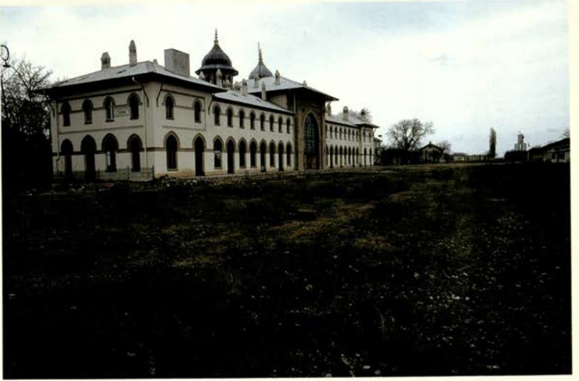
Eski Tren Gari (Peron Cephesi)
