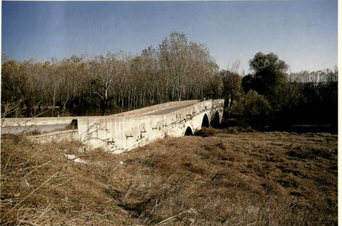
Yalnız Göz Köprüsü
