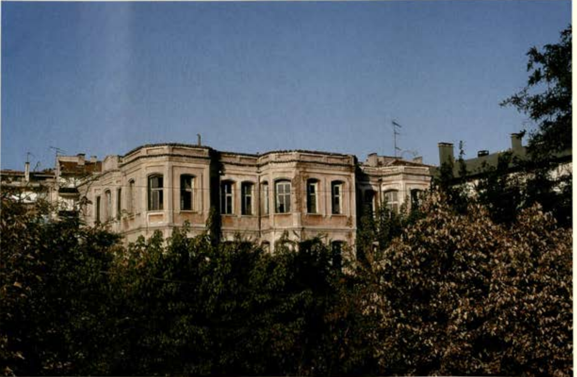
Talât Paşa Asfaltında Dertli Mustafa Efendi Konağı
