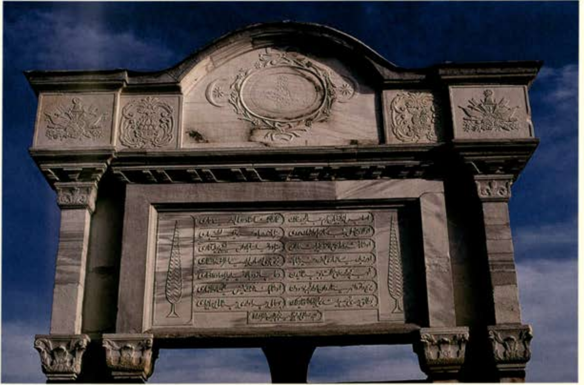
Yeni Köprü (Meriç Köprüsü) tarih köşkü ve kitabesi
