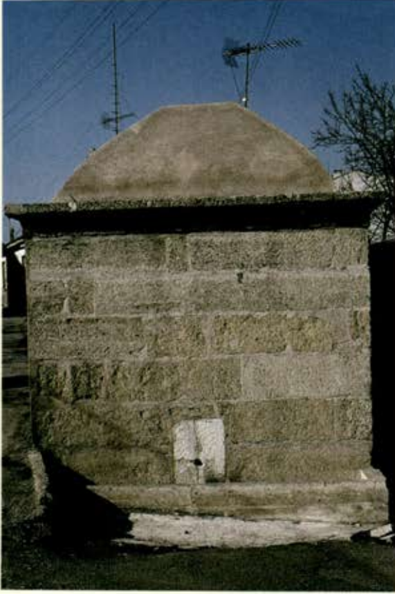
Çavuş Bey Mahallesiinde Yelli Burgaz Çeşmesi
