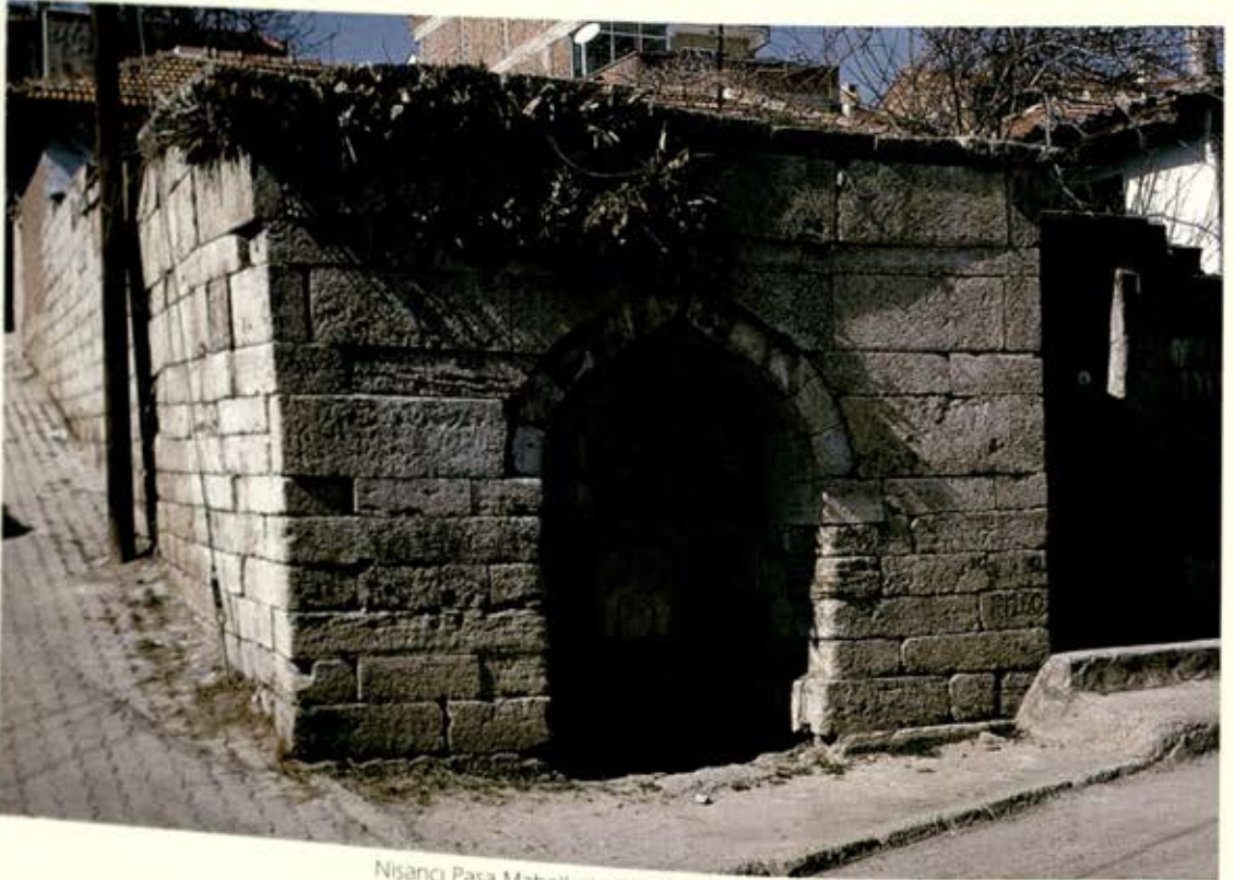
Nişancı Paşa Mahallesinde Atlar Çeşmesi
