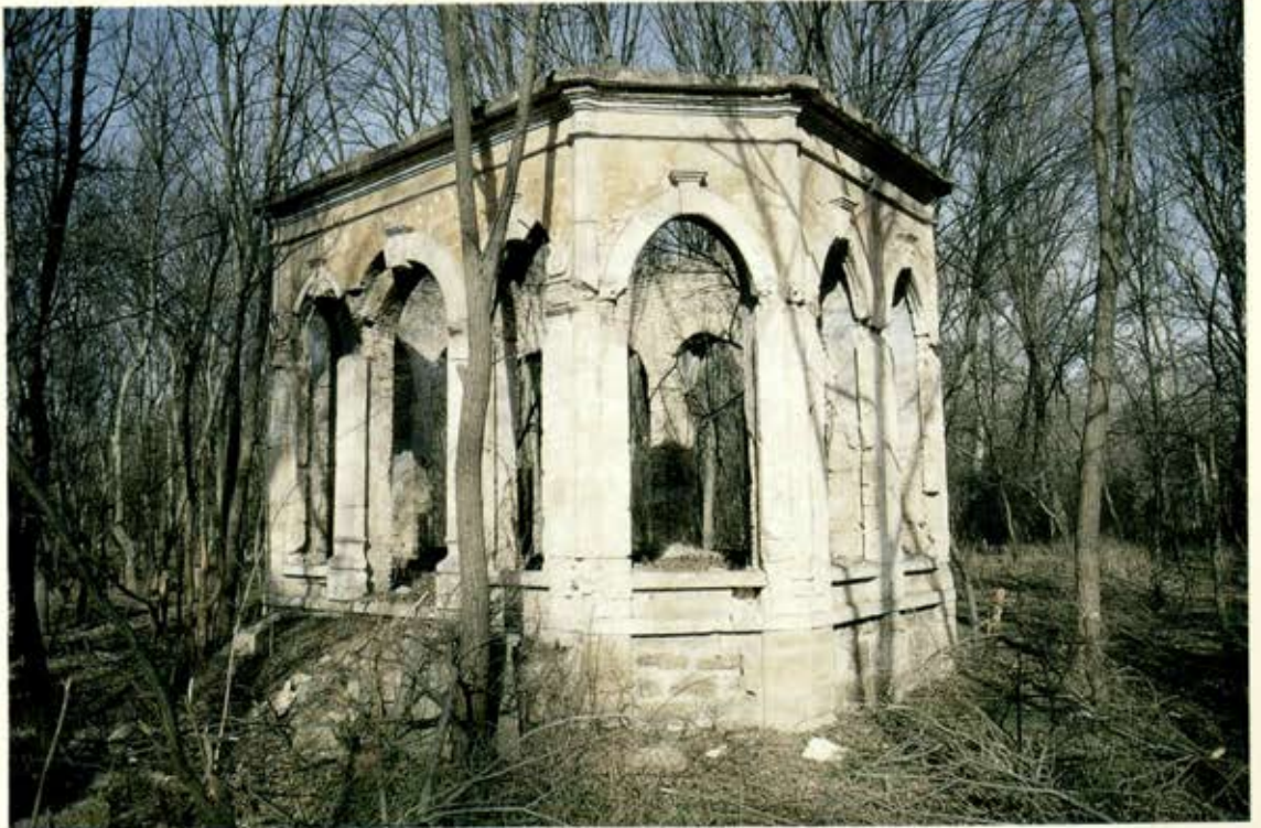
Tavuk Ormanında Av Köşkü
