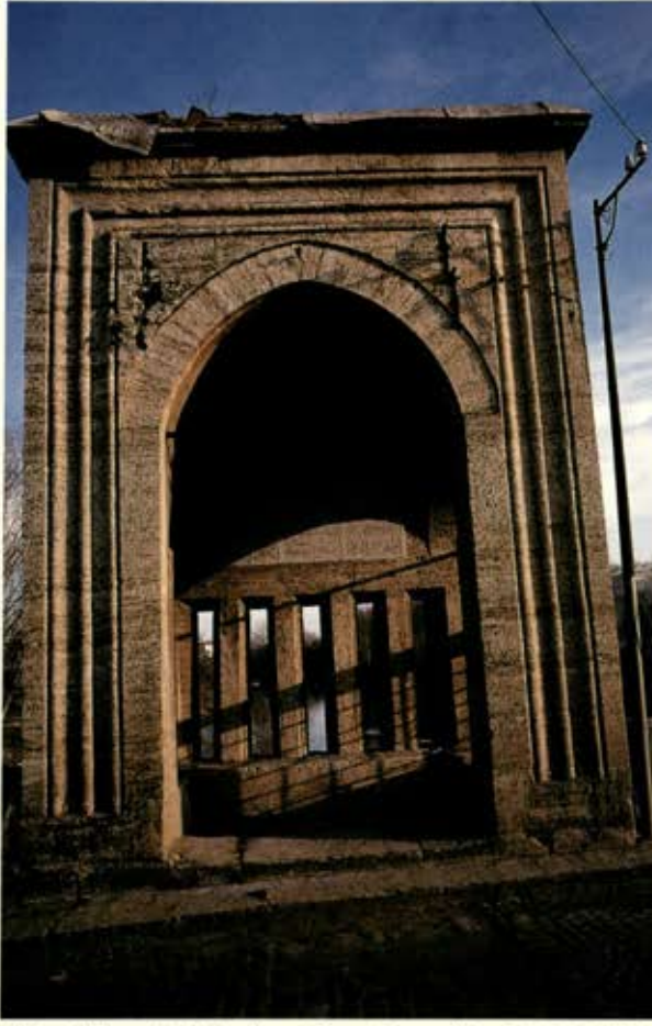
Eski Köprü [Ekmekçi Zâde Ahmet Paşa, Tunca Köprüsü Tarih Köşkü]
