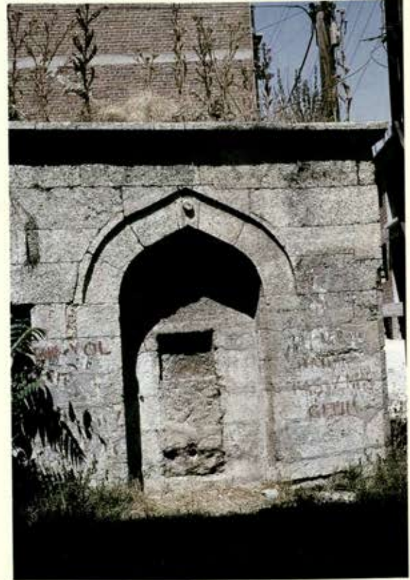
Meydan Mahallesi Hatip Çeşme
