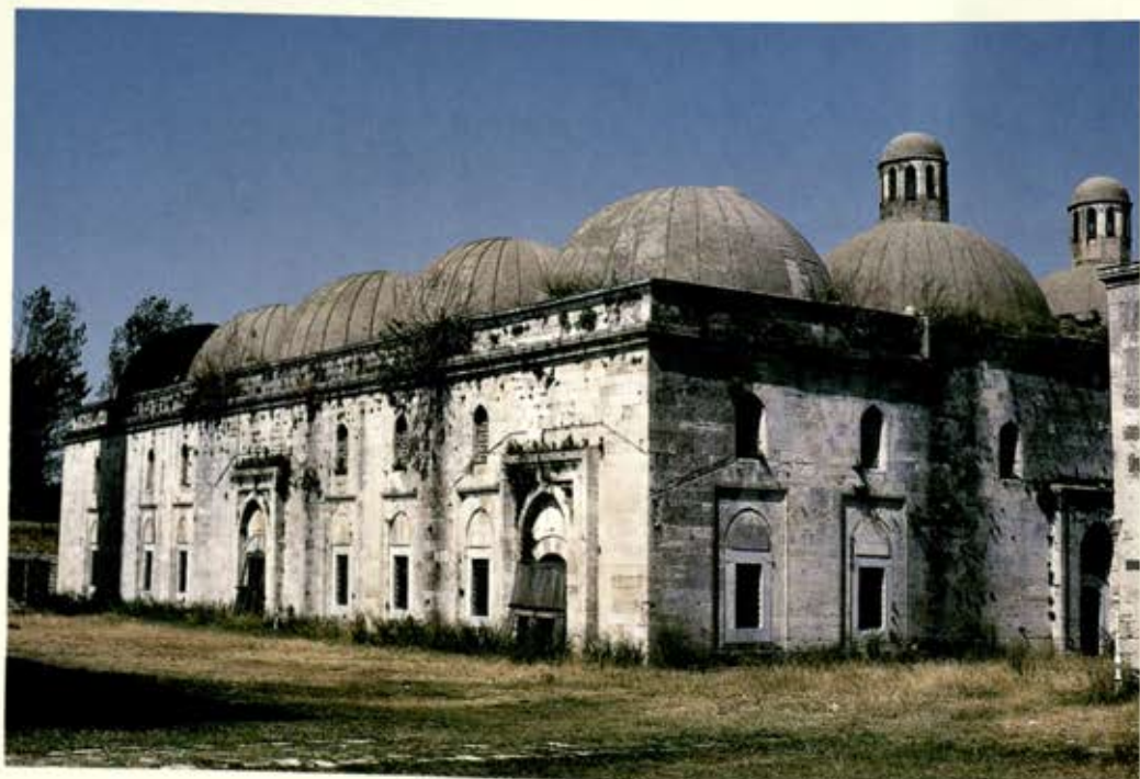
II. Bayezid Külliyesi Imarethanesi
