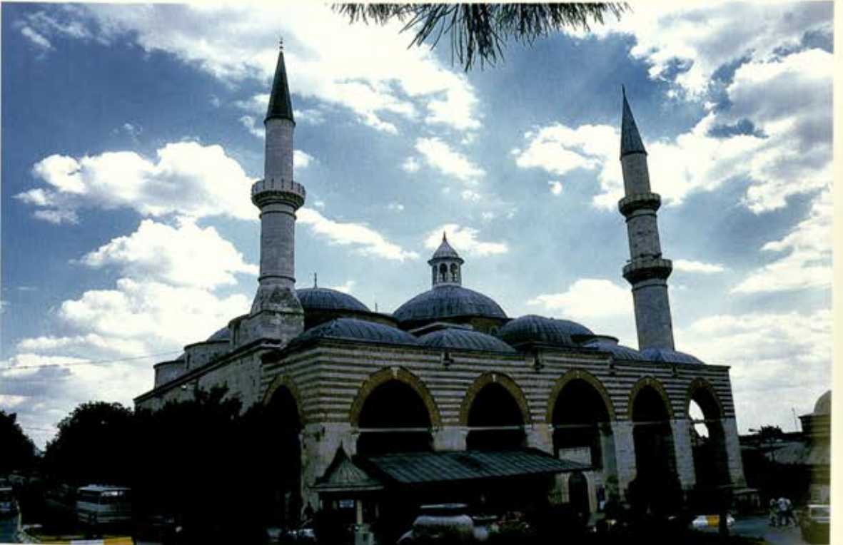
Eski Cami ön ve yan cephe
