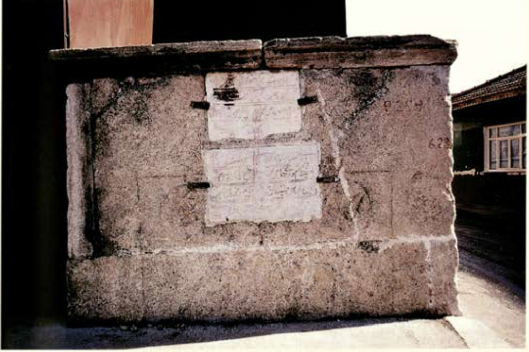
Abdurrahman Mahallesinde Solak Ali Ağa Çeşmesi
